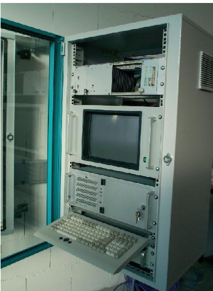
Auswerteelektronik: Die an der Messschwelle gewonnenen Daten werden durch an den Gleisanlagen platzierte Auswerterechner mit Infrarot-Einschub verarbeitet und an übergeordnete Systeme weitergereicht. Anlagen dieses Typs sind in mehreren europäischen Ländern in größeren Stückzahlen installiert.
